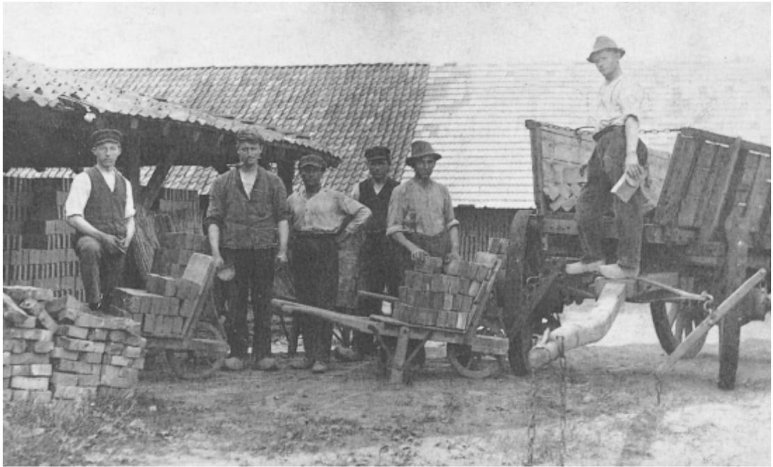
*Verpacken der Steine auf einen zweispännigen Pferdewagen zum Abtransport, Ziegelei Lueb (Werk I)*
