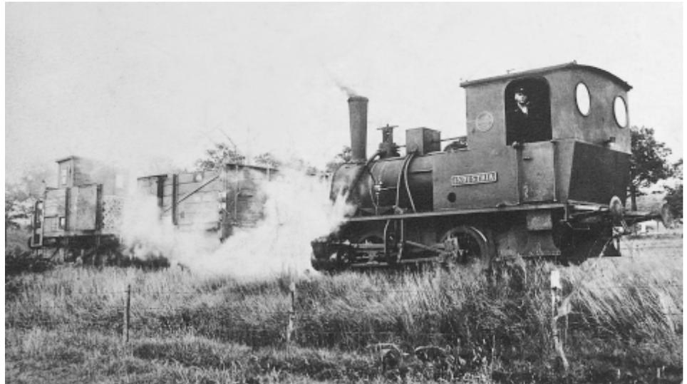
*Unter Dampf! Lokführer Weyer mit seiner Dampflokomotive und einem Waggon voll Ziegelsteinen auf dem Anschlussgleis unterwegs zur Strecke Bocholt-Wesel. Auf dem Waggon kann man durch die geöffnete Luke die Ziegelsteine erkennen. Um Beschädigungen an den Steinen zu vermeiden, wurden die Steine im Zick-Zack System auf den Waggonen verpackt. Die Lok war eine typische Industrielok für Werksbahnen, am Waggon erkennt man an der Stirnseite noch ein Bremserhäuschen.*
