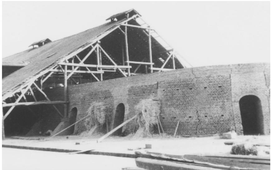
*Teilweise abgebrochenes Ringofendach mit zwei neugegossenen Fundamenten für die Stützpfiler der neuen Dachkonstruktion
